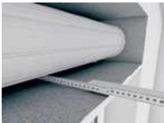
2. Mesurer les dimensions intérieures du coffre pour déterminer la longueur et l'épaisseur du panneau
