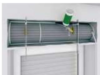
7. Coller de manière étanche avec de la mousse de montage les jointures des panneaux entre eux et en butée.
