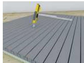
3. Reporter les dimensions sur le panneau ISOFLEX pour le découper sur mesure. Le cas échéant, effectuer une entaille pour le passage de la sangle ou du câble du moteur.
